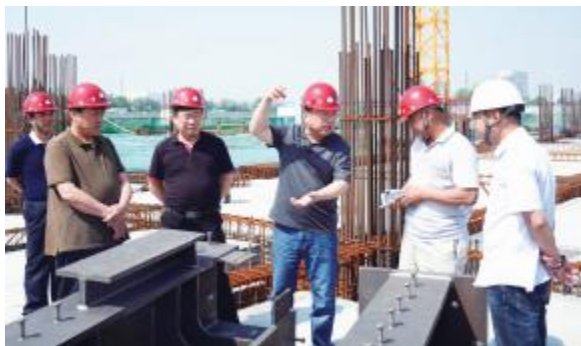
6月8日,区领导调研咸水沽医院项目(董山虎提供)
