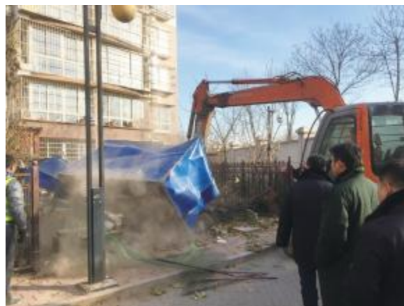
12月7日，拆除海天馨苑小区违章建筑（区综合执法局提供）
