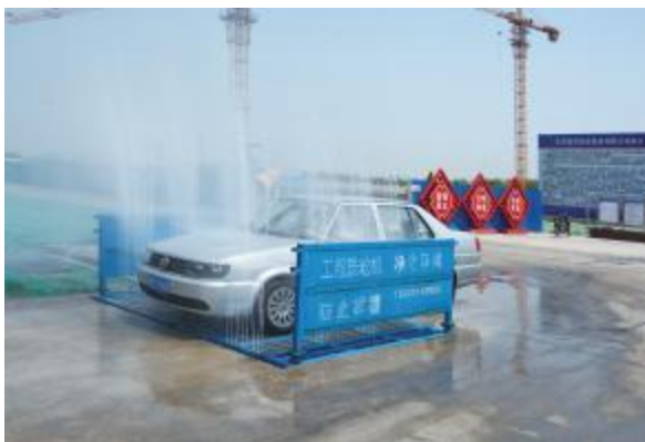
施工现场冲洗进出车辆（董山虎提供）
