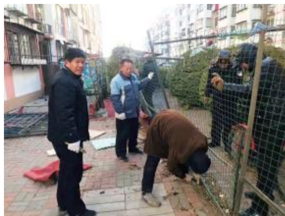
拆除违章建筑（北闸口镇政府提供）
