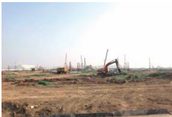
葛沽镇棚户区改造项目施工现场（白于巾提供）
