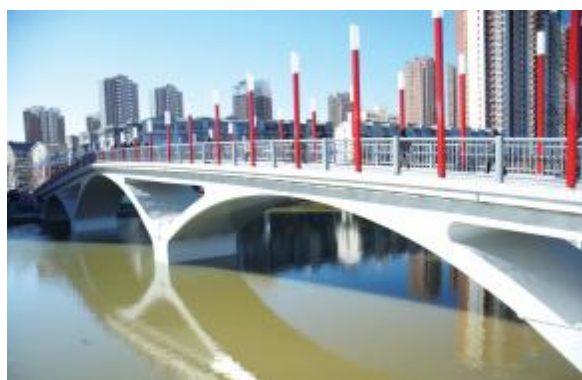
12月23日，海河故道人行景观桥竣工通行（董山虎提供）
