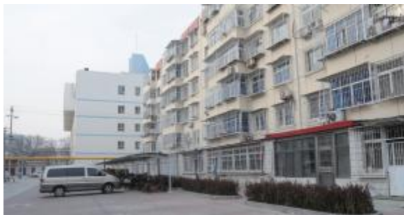
咸水沽镇部分小区综合改造提升工作(咸水沽镇政府提供)
