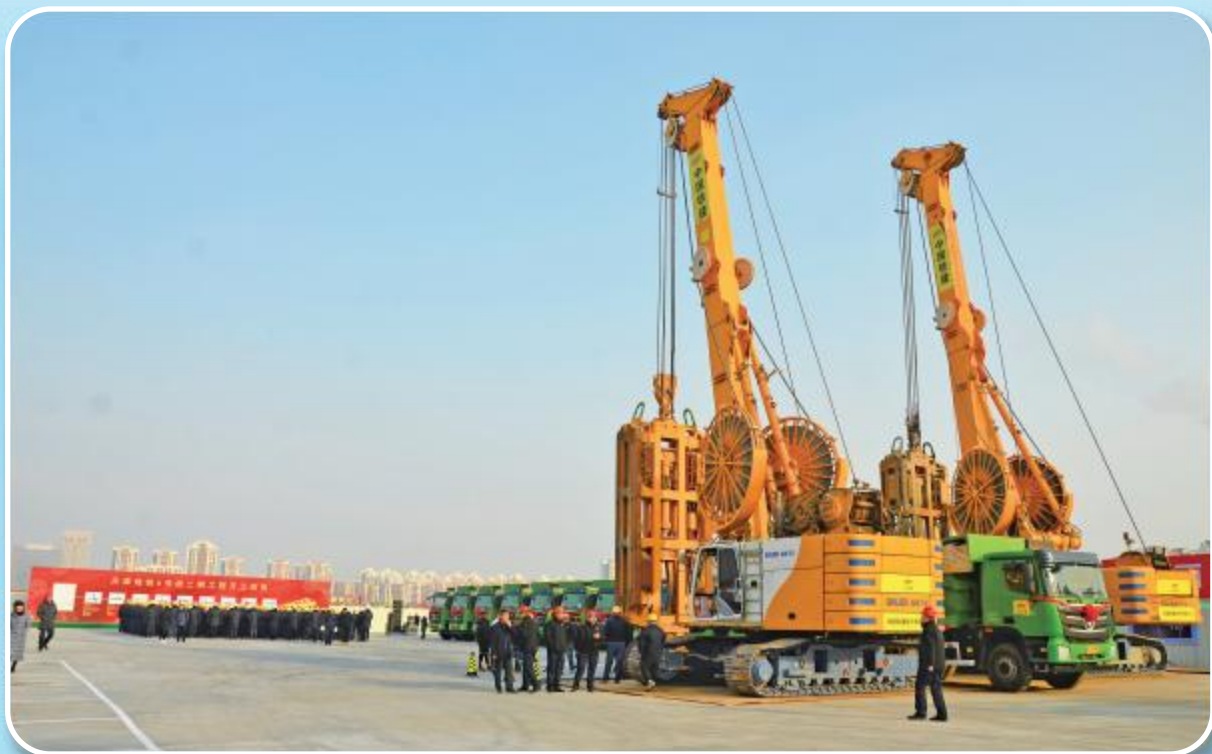
2019年2月4日，天津地铁6号线二期工程开工（沈欣提供）
