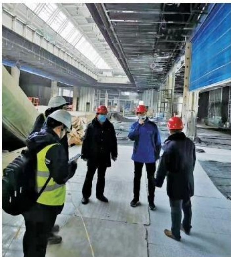
2020年12月，检查国家会展中心(天津)工程厂区特种设备安全运行情况(区市场监管局提供)
