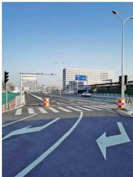
2020年9月，施工完成后的安荣道(区住建委提供)
