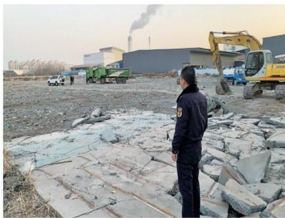
12月19日,重点项目拆建工作(经济开发区管委会提供)
